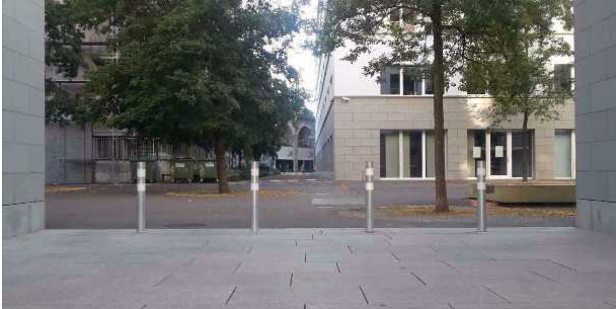
Bild: Abnehmbare Absperrpfosten bei einer Feuerwehrdurchfahrt
